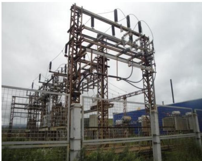
Рисунок 3.24 – система шин ПС 35 кВ г. Курильск
