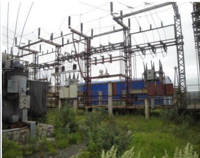
Рисунок 3.25 – Тр-р и секционный выключатель
