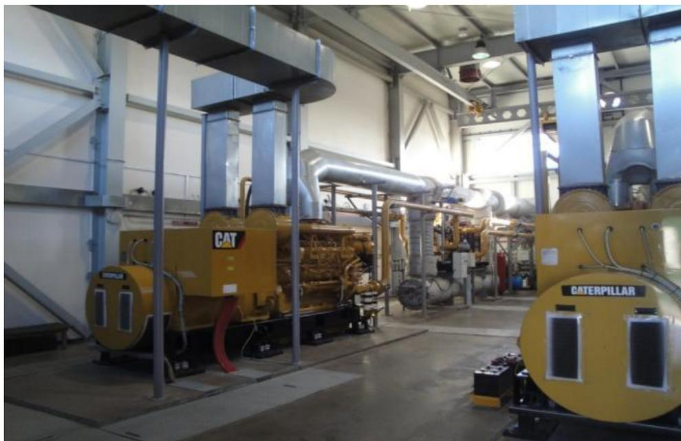
Рисунок 3.4 – Когенерационная установка КАТЕРПИЛЛАР установленной мощностью 1088 кВт
