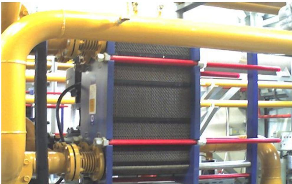
Рисунок 3.6 – Модуль теплообменника контуров двигателя
