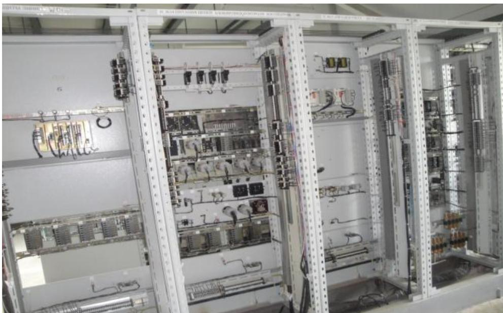
Рисунок 3.8 – шкафы РЗА на электромеханической базе
